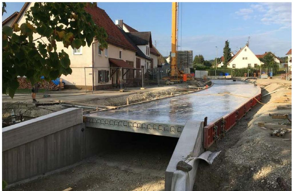
Der nach unten offene Rechteckdurchlass mit einer lichten Breite von 4,30 m und einer lichten Höhe von mindestens 1,20 m härtete in dieser Woche aus.
