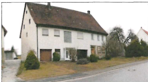
Abb.9: Gebäude im Plangebiet an der Sulzer Straße
