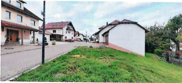
Abb. 4: Ansicht des Plangebietes in südwestlicher Richtung.
