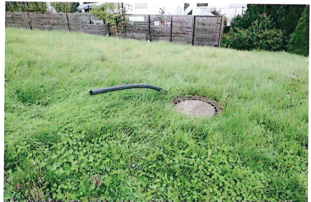
Abb. 9: Innerhalb des Plangebietes vorhandener Schacht.
