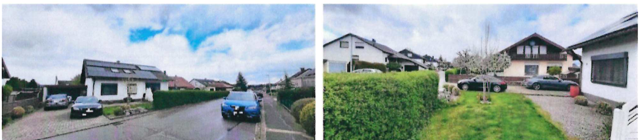
Abb. 5: Ansicht der westlichen Fassade des Wohnhauses im südlichen Geltungsbereich.
