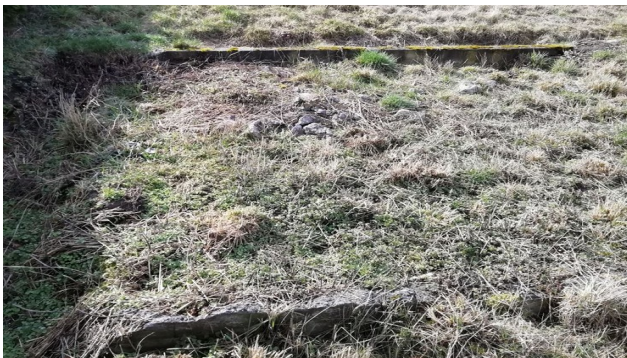
Abb. 10: Streifenfundamente des ehemaligen Gewächshauses
